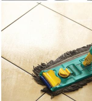
La pulizia “dopo posa” serve per rimuovere i residui di: stucchi per le fughe, cemento, calce, boiaccia. È obbligatoria a fine cantiere, sia per le piastrelle smaltate che per quelle non smaltate. La pulizia non deve essere eseguita se le superfici piastrellate sono molto calde (es. esposte al sole nei mesi più caldi), perchè diviene più severa l’azione degli aggressivi chimici. In estate effettuarela nelle ore fresche della giornata.
